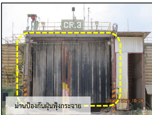
ภาพที่ 2.9 อาคารบดย่อยหินเป็นแบบปิดและติดตั้งระบบดักฝุ่นชนิด Bag Filter และม่านป้องกันฝุ่นฟุ้งกระจายเพื่อป้องกันฝุ่นออกสู่ภายนอก
